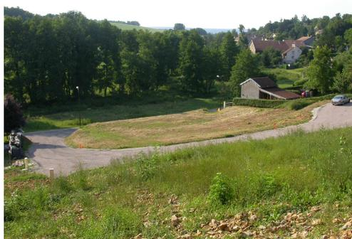
Les travaux de viabilisation du lotissement communal, « les Coteaux de la Roche » sont maintenant terminés à l'exception des travaux de finition de la voirie et de l'installation des candélabres d'éclairage public.
